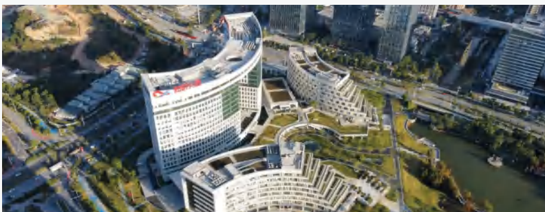
广州知识城大厦项目施工总承包建筑幕墙工程及建筑幕墙工程设计项目 荣获2021-2022年度中国建筑工程装饰奖
