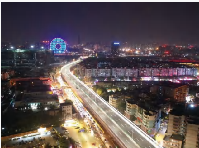
广东省第一个全装配式桥梁工程——芳村快捷化改造工程
