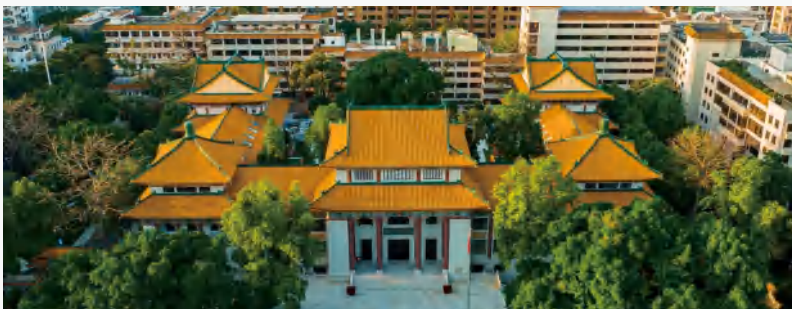
园建公司承建的解放军进城式检阅台（含市府大楼）文物修缮工程施工工荣获 2022年度中国风景园林学会科学技术奖（园林工程奖）金奖
